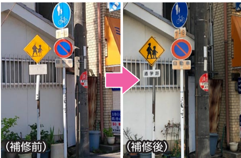
▲喜連小学校前通学路標識の劣化による付替
