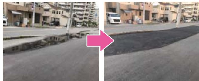
(補修前) ▲加美東3丁目歩道の水溜り補修 ▲(補修後)
